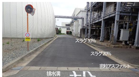
写真-9 試験施工サイト (手前が進入路)
