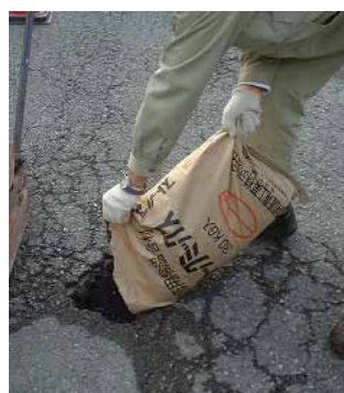
敷き均し状況
