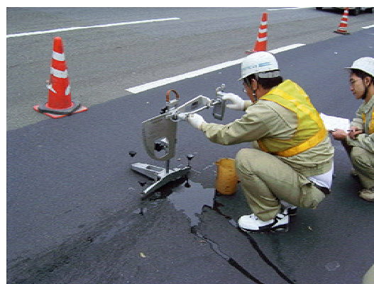
写真. 地方道の坂道での施工例(密粒ギャップ) すべり抵抗性試験 (BPN) 状況
