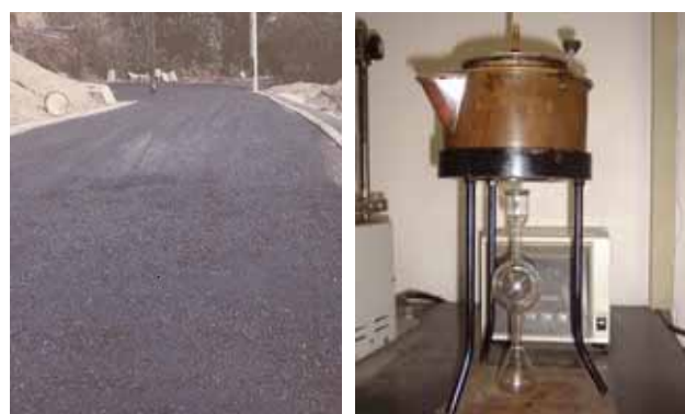
散布現場状況 品質試験(エングラード)
