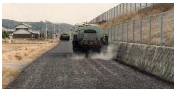
シールコート現場施工状況
