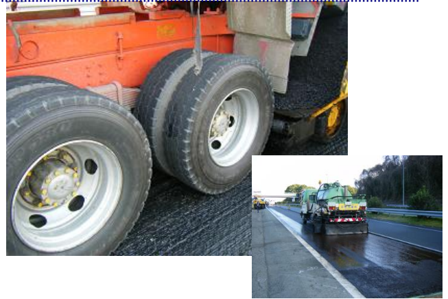
乳剤のタイヤへの付着と散布状況
