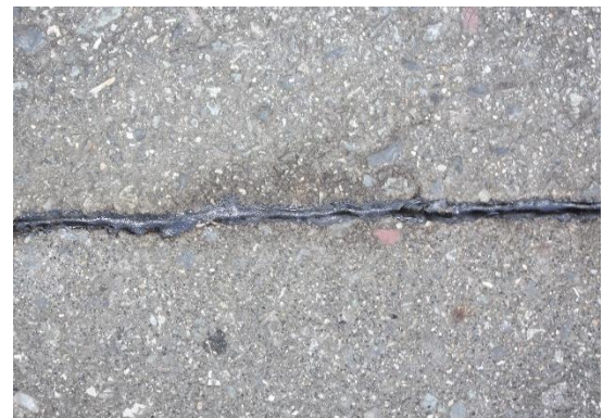
注入後の状況
